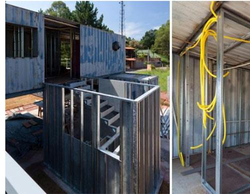
Figura 5 – Escada em Steel Frame (CALORY, 2015)
